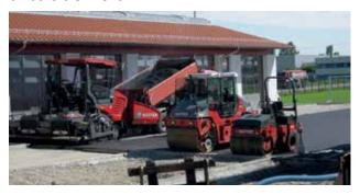
Der Neubau des Feuerwehrhauses geriet so langsam ins Endstadium. So wurde der Außenbereich asphaltiert und gepflastert und die Grünanlagen wurden ebenfalls schon angesät.
