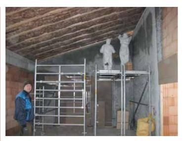
Kopfüber werden Dämmung und Dampfsperre angebracht. Alles in allem eine recht kratzige Angelegenheit, daher der weiße Vollschutz.
